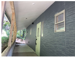
F (284坪) 建物(26坪) 25,000,000円 R4年6月建築
